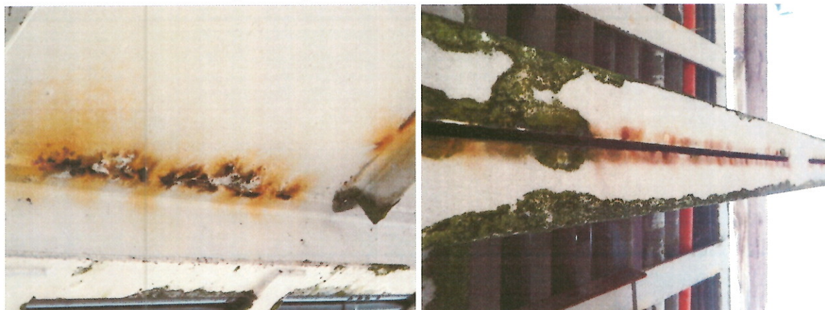
Obrázek 5 Korozní napadení spodních ploch lávky
