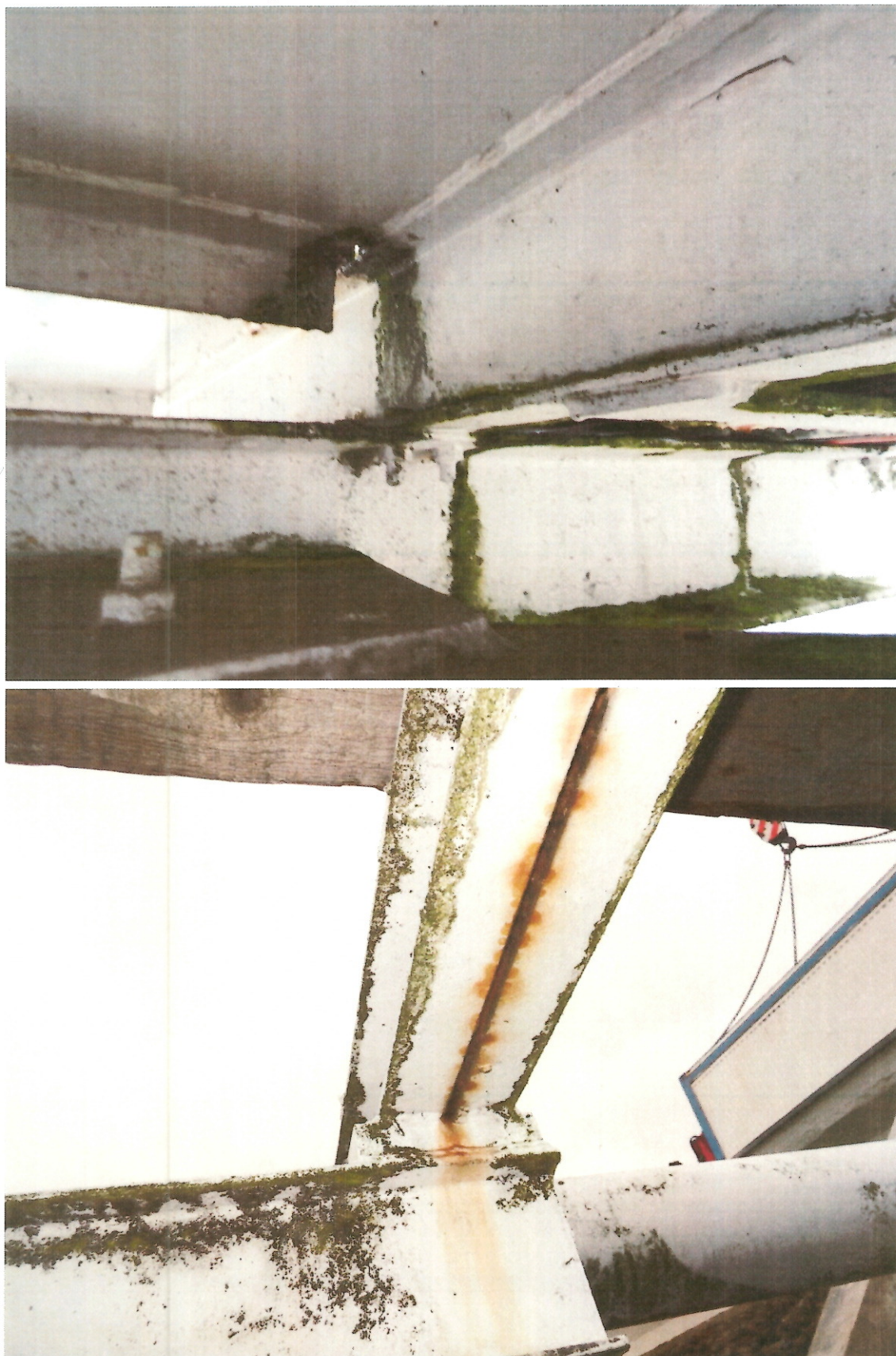
Obrázek 4 Korozní napadení spodních ploch lávky
