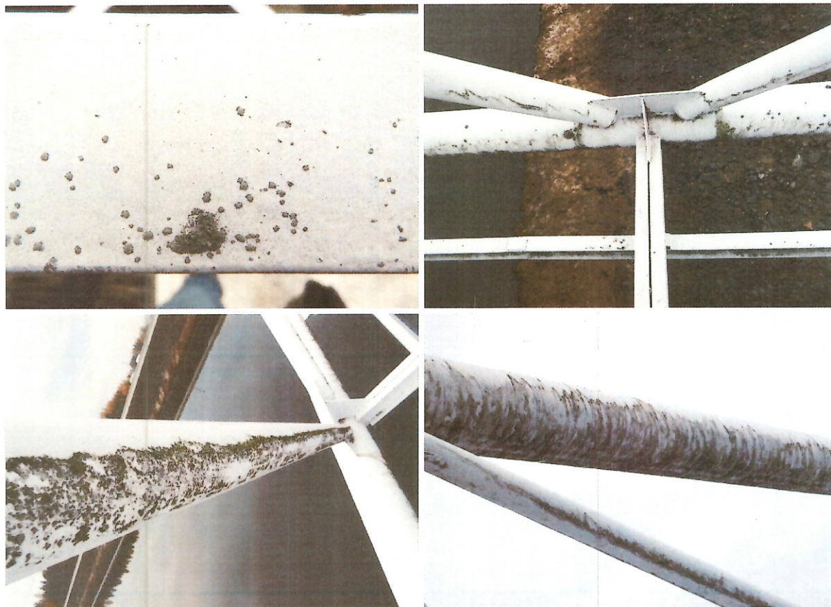
Obrázek 2 Biologické úsady na konstrukci
